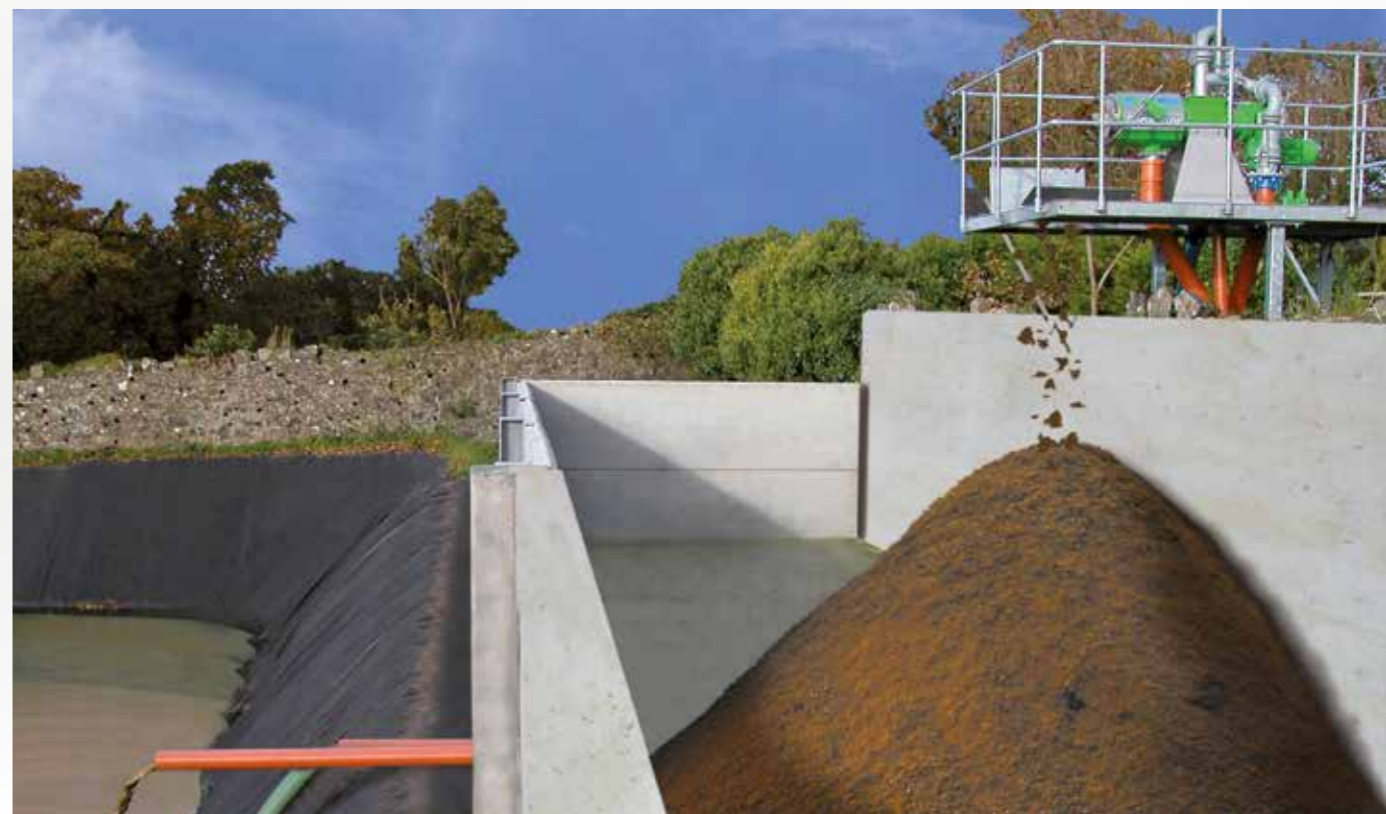
Wiederverwertung von separierter Dünngülle für das Spülsystem
