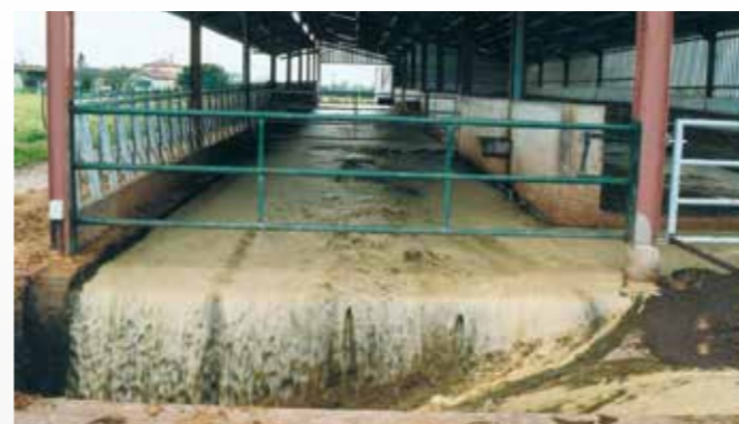
Wiederverwertung von separierter Dünngülle für das Spülsystem
