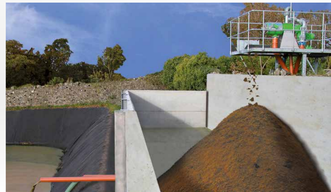
Ré-utilisation du lisier liquide séparé pour le système hydrocurage
