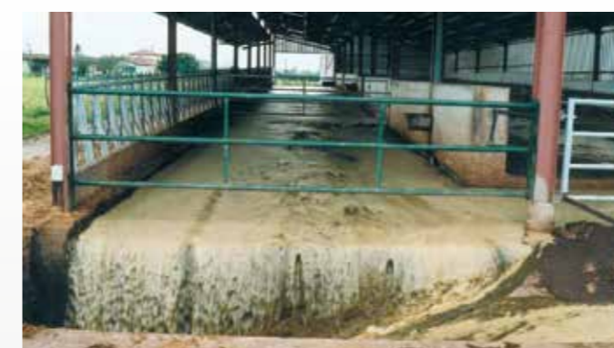
Ré-utilisation du lisier liquide séparé pour le système hydrocurage
